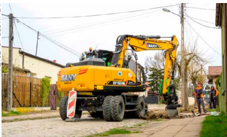
Prace na osiedlu Przybyłów
