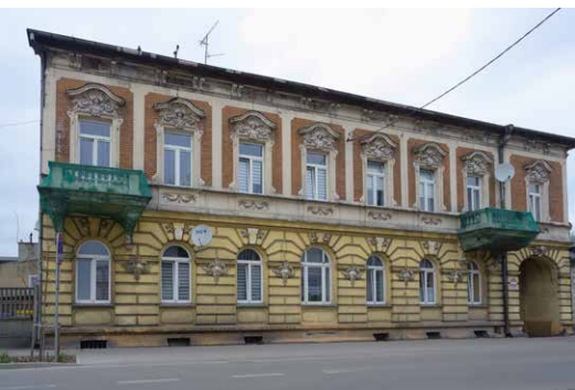
Jedna z najpiękniejszych zgierskich kamienic przy ul. Dąbrowskiego 25 jest na liście budynków do modernizacji energetycznej
