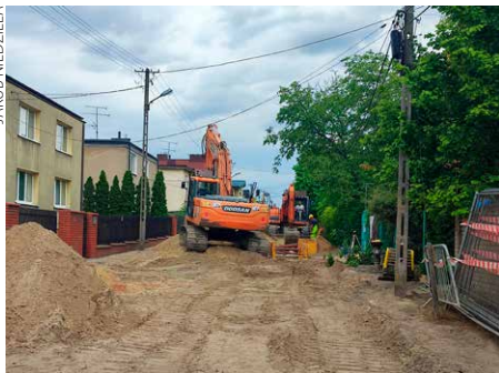
Prace w okolicach placu Targowego
