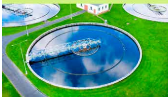
• przydomowe oczyszczalnie ścieków
