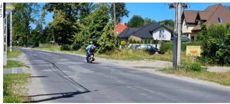
Na celowniku: przebudowa pierwszego odcinka Wiosny Ludów
