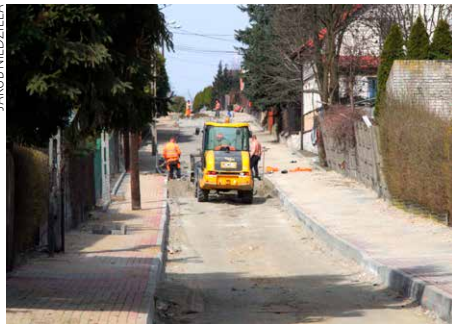
Prace wykonywane są w ramach zadania „Przebudowa dróg na terenie Gminy Miasto Zgierz” dofinansowanego przez Rządowy Fundusz Rozwoju Dróg
