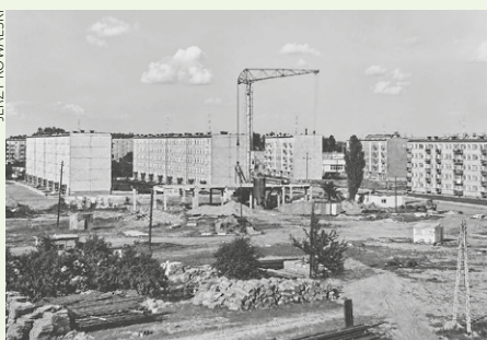
Lata 70. Pawilon Bogdanki na Osiedlu 650-lecia dopiero w budowie
